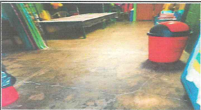
Foto 3: cambio de piso a piso cerámico
