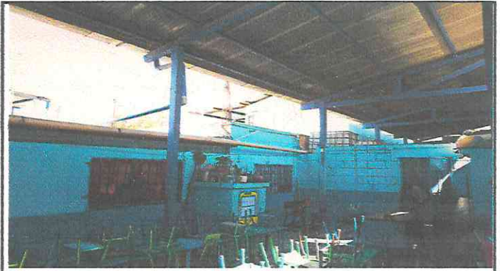
Foto 2: Cubierta de lámina
